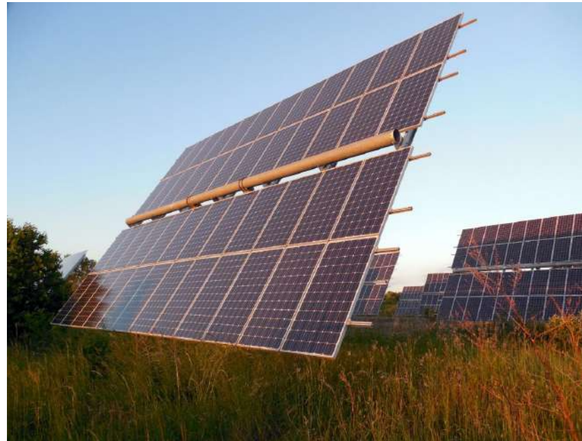
Instalación en el suelo
